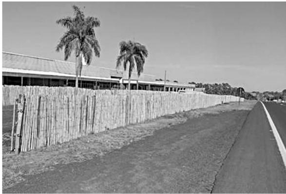
Além de durar décadas na forma in natura, o bambu perfurado elimina a poluição visual do material de fresa exposto na faixa de domínio e confere mais segurança ao condutor que precisa utilizar o acostamento. A delimitação com uma solução ecológica elimina a necessidade de utilizar material industrial, como defensas metálicas.
